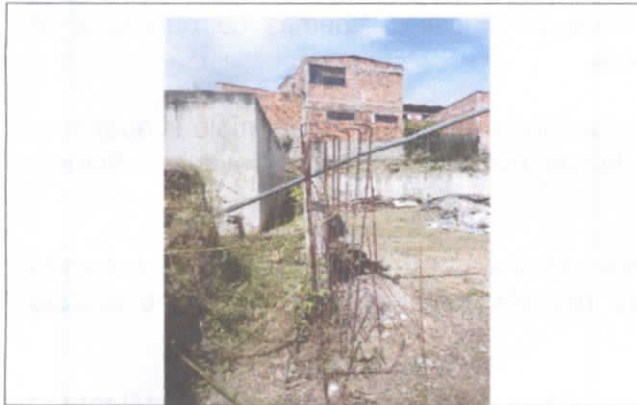
35. Muro de contención. No contiene ningún talud
