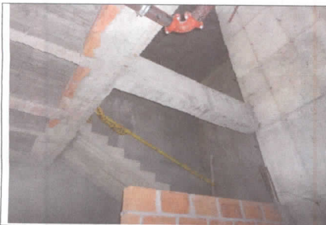
23. Aparentemente una viga, pero no se entiende su continuidad. Es una viga que no aporta, sino que genera un peso innecesario
