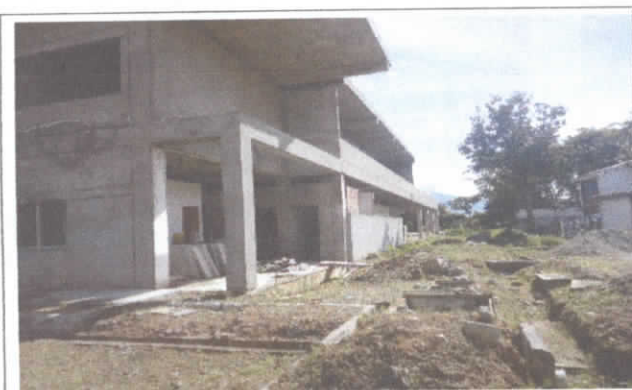
1. Fachada con ésta patología Constructiva
