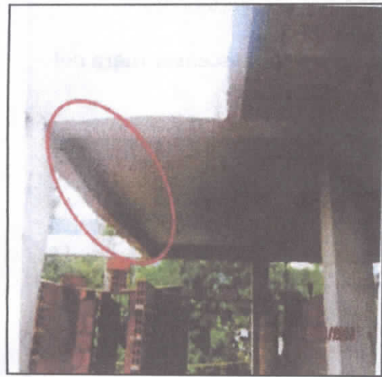
- Deflexión de la placa de cubierta
