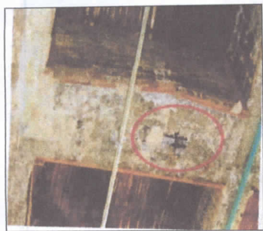
- Deflexión de la placa de cubierta
