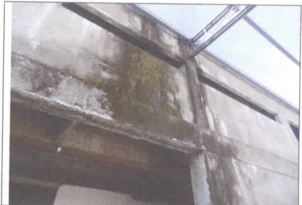
30. Biopelículas no solo en piso, sino también en mampostería, incluso exteriores
