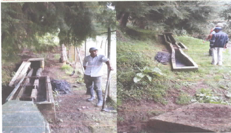
Plantas de Tratamiento de Aguas residuales PTAR N° 1 el Matadero y N° 2 Circunvalar del Municipio de Santa Isabel. Junio 2017.
