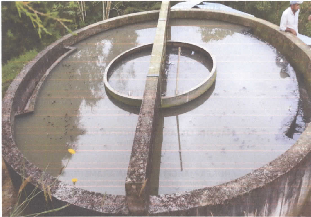
Planta de Tratamiento de Aguas residuales PTAR . Santa Isabel. Junio 2017.
