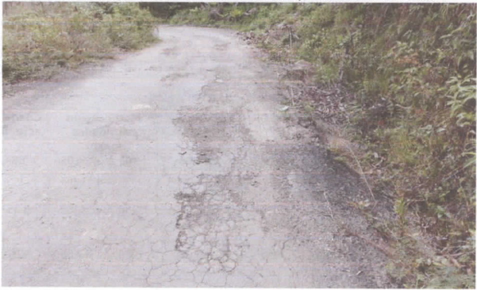
FOTO N° 3 .ACTA NO. 002 VISITA TECNICA DE CAMPO A LAS ÁREAS DE DESARROLLO DEL EL CONTRATO No. 363 DEL 22 DE NOVIEMBRE DE 2016, PLANADAS – CERRAJOSA – PAN DE AZUCAR, DEL MUNICIPIO DE CAJAMARCA.
