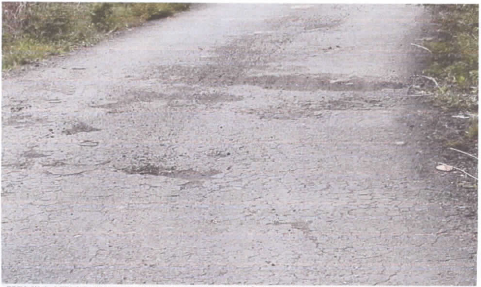
FOTO N° 4 .ACTA NO. 002 VISITA TECNICA DE CAMPO A LAS ÁREAS DE DESARROLLO DEL EL CONTRATO No. 363 DEL 22 DE NOVIEMBRE DE 2016, PLANADAS – CERRAJOSA – PAN DE AZUCAR, DEL MUNICIPIO DE CAJAMARCA.
