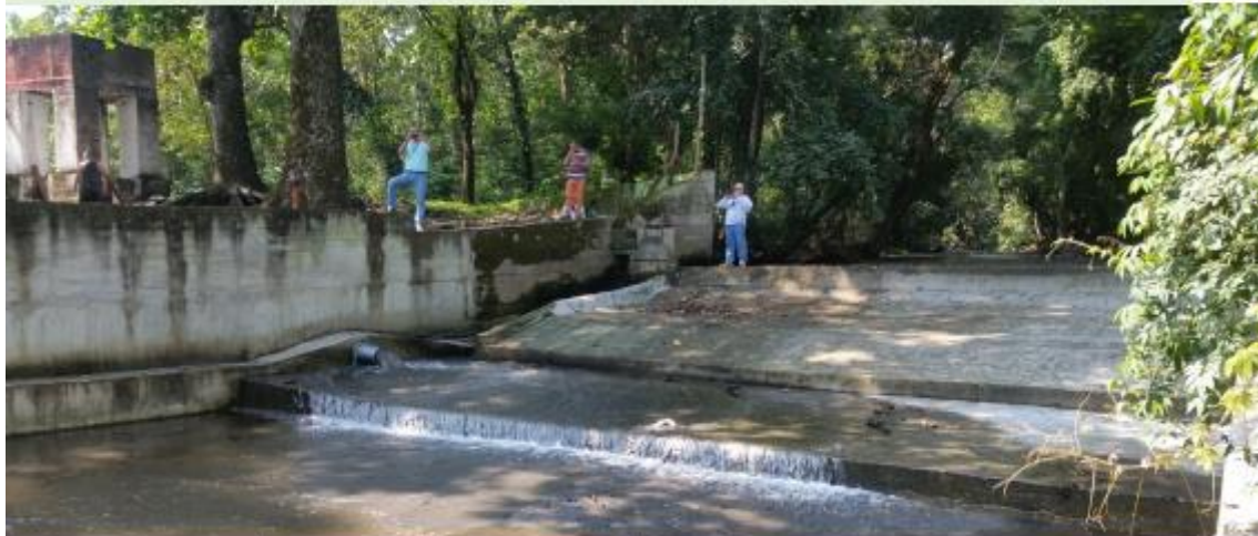
Foto N° 5. Bocatoma y Tanque Desarenador del Acueducto de HONDA TRIPLEAAA, Rio Medina .2017
