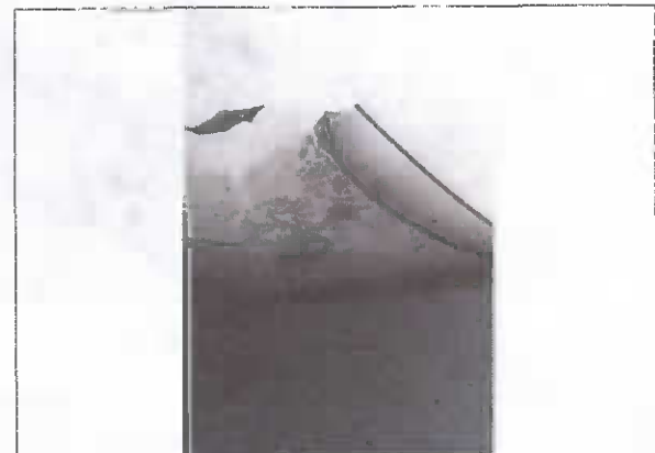
10. Acero expuesto en la parte inferior del mesón
