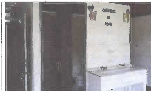
21. Baterías sanitarias nuevas de otro contrato
