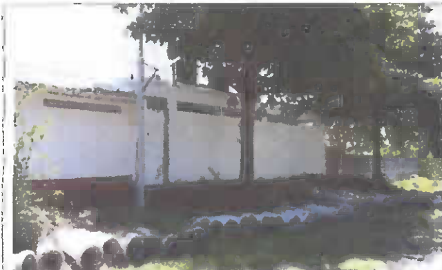
11. Fachada desde la vía pública
