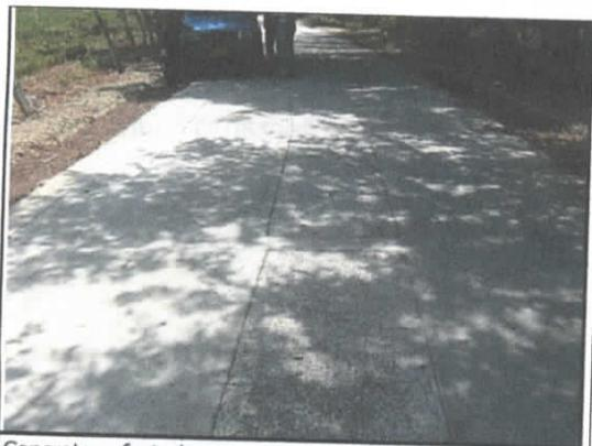
Concreto afectado por un mal proceso constructivo llamado sedimentación por demasiada presencia de agua en el momento de la aplicación.
