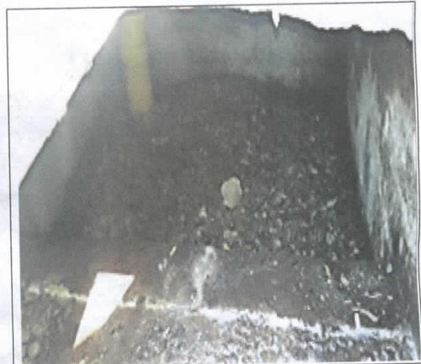
Gravilla interna actuando como filtro. Tubería de 4" para evacuar.
