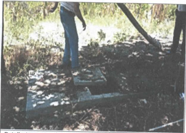
Detalle tapa con elemento para facilitar su extracción. Aunque no tiene ángulo metálico
