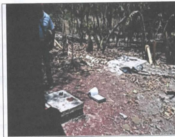
4. Vista general. De izquierda a derecha: Caja de inspección, pozo séptico y campo de infiltración.
