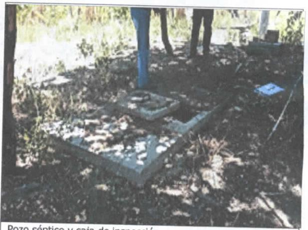
Pozo séptico y caja de inspección
