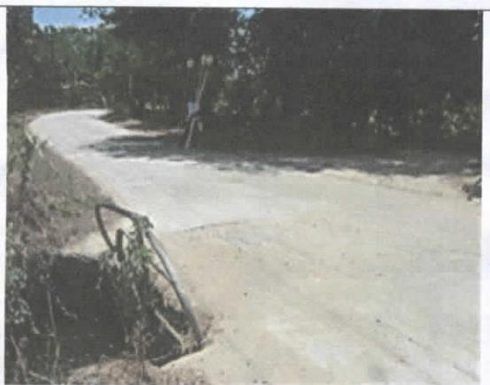
Desgaste prematuro de la superficie del pavimento.
