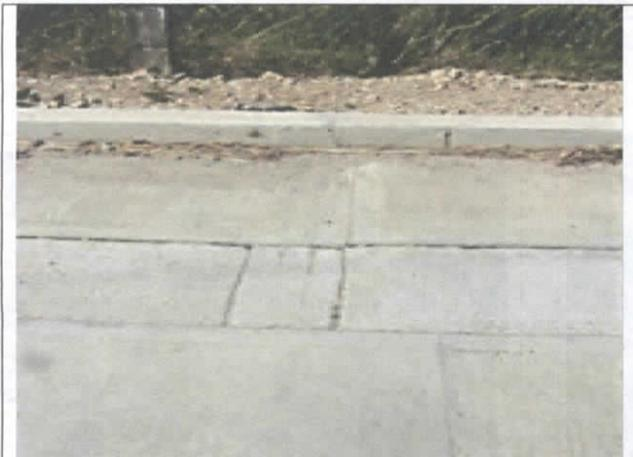
Aplicación y unión de diferentes elementos en concreto, muy anti técnico y trasmisión de fisura al sardinel.
