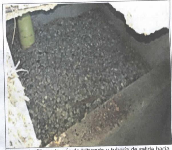
Elemento filtro a través de triturado y tubería de salida hacia el campo de infiltración 4". Mampostería con pañete.
