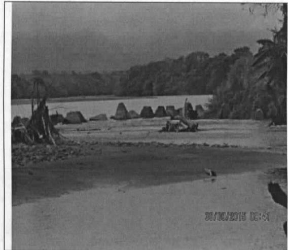
Contrato N° 246 de 2014 Construcción de tetraedros en concreto reforzado para mitigar la erosión de la ribera izquierda del rio Magdalena en el Municipio de Natagaima – Tolima – Verificación en sitio funcionamiento del sistema construido
