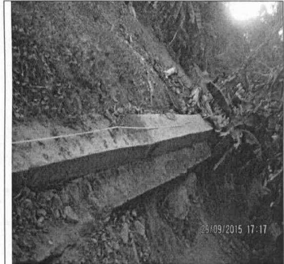
Contrato N° 249 de 2014 optimización del sistema de alcantarillado del casco urbano del Municipio de Natagaima B. El Limonar revestimiento en concreto en diferentes tramos de la tubería
