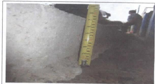
2. Espesor del pavimento mínimo 15 cm.
