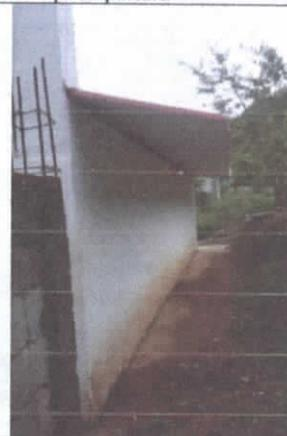
14. Cubierta sin estructura (anti sísmico)
