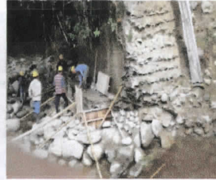
Concreto ciclópeo cimentación recalce de estribo y mejoramiento.
