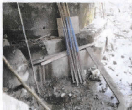
Concreto ciclópeo cimentación recalce de estribo y mejoramiento.
