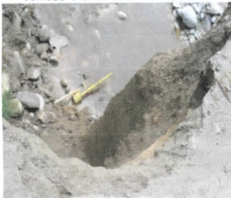
Antes de la intervención
