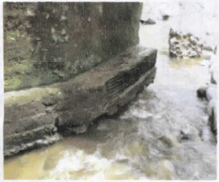
Concreto ciclópeo cimentación recalce de estribo y mejoramiento.
