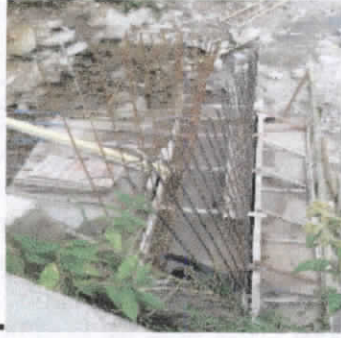
Acero de Refuerzo
