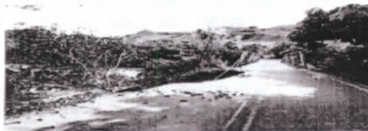
Zona de la vía afectada, vista desde Rioblanco hacia Chaparral.
