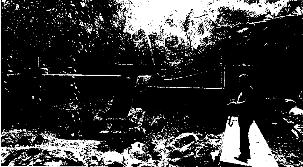
REPRESA SOBRE LA QUEBRADA LA PALMARA
