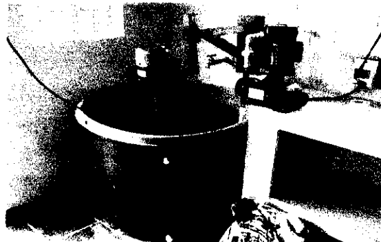
Foto No 10 Dispensador de cloro y sulfato corregimiento de Santiago Pérez-Ataco
