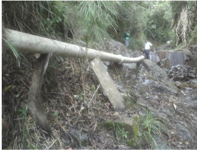
Foto No 23 Redes de aducción en peligro en el municipio de Roncesvalles
